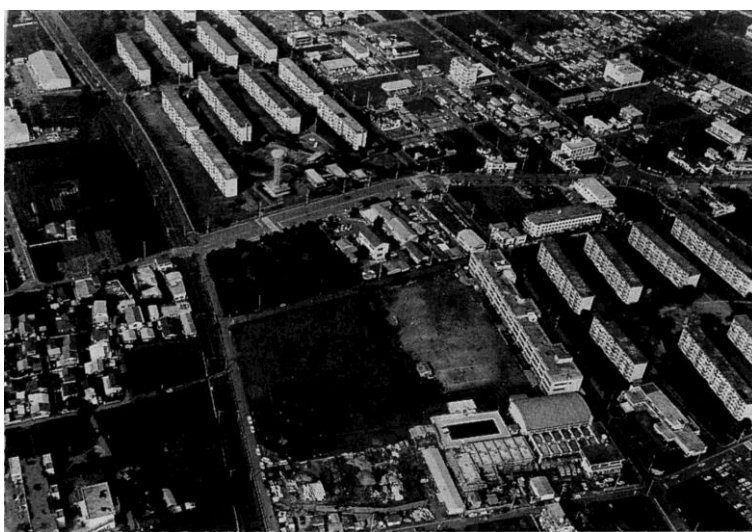
写真：完成した富士見台団地（「くにたちの歴史」より）
