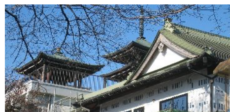
図7 三重塔と鐘楼
